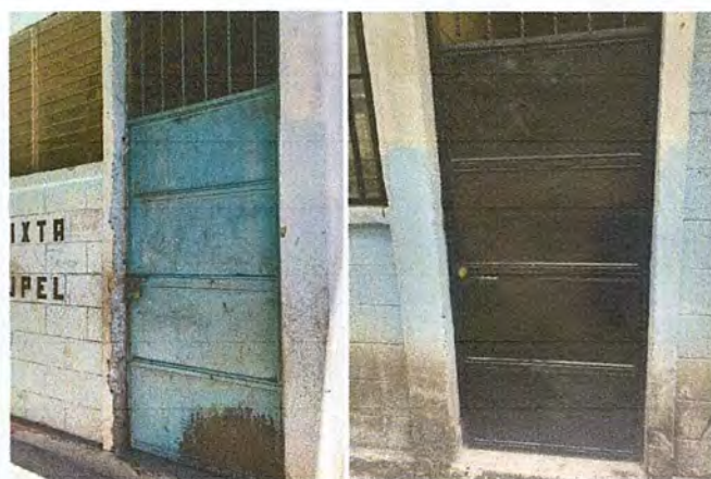
Foto 4: MEJORAMIENTO E INSTALACION DE PUERTAS
